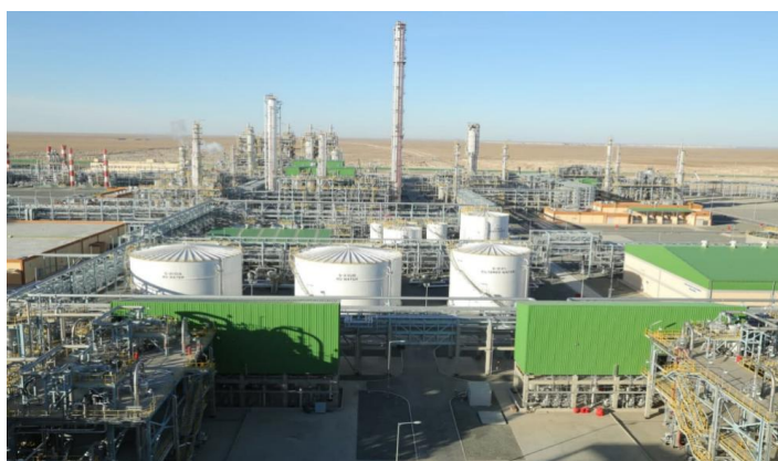
Рис. 2. Территория Устюртского газо-химического комплекса «Uz-Kor Gas Chemical» (2023 г.)
